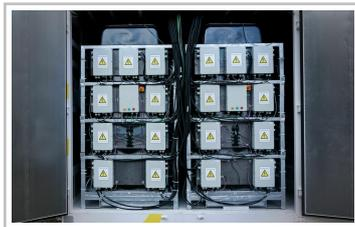
Stationärer Energiespeicher in Elverlingsen mit 72 Antriebsbatterien aus dem Renault Zoe.
