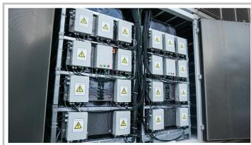
Stationärer Energiespeicher in Elverlingsen mit 72 Antriebsbatterien aus dem Renault Zoe.
