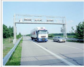
Kontrollbrücke zur Überwachung der Lkw-Maut.
