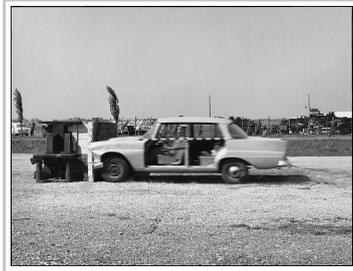
Mit dem Frontalaufprall eines Fahrzeugs der Baureihe W 111 begannen am 10. September 1959 die Crashtests von Mercedes Benz. Es ist das erste Automobil der Welt mit gestaltfester Fahrgastzelle und Knautschzonen an Front und Heck.
