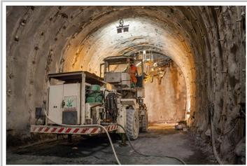
Vorbereitung einer Sprengung bei den Bauarbeiten am Brenner-Basistunnel.
