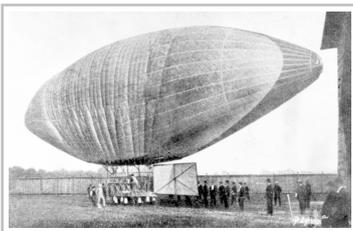
Experimentelle Flugversuche mit lenkbaren Ballons unternimmt der Leipziger Buchhändler Dr. Karl Wölfert viele Jahre lang. Zu seinem Luftschiff „Deutschland“ liefert ihm Gottlieb Daimler 1896 den 7 PS (5,1 kW) starken Zweizylinder-Phönixmotor mit Leichtmetall-Kurbelgehäuse. Wölfert unternimmt mehrere erfolgreiche Probefahrten. Im Juni 1897 stürzt er tödlich ab, als der Ballon in Flammen aufgeht.
