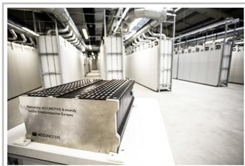
Die Stadtwerke Hannover (Energcity) haben Ersatzbatterien für den Smart Electric Drive zu einem stationären Stromspeicher gebündelt.
