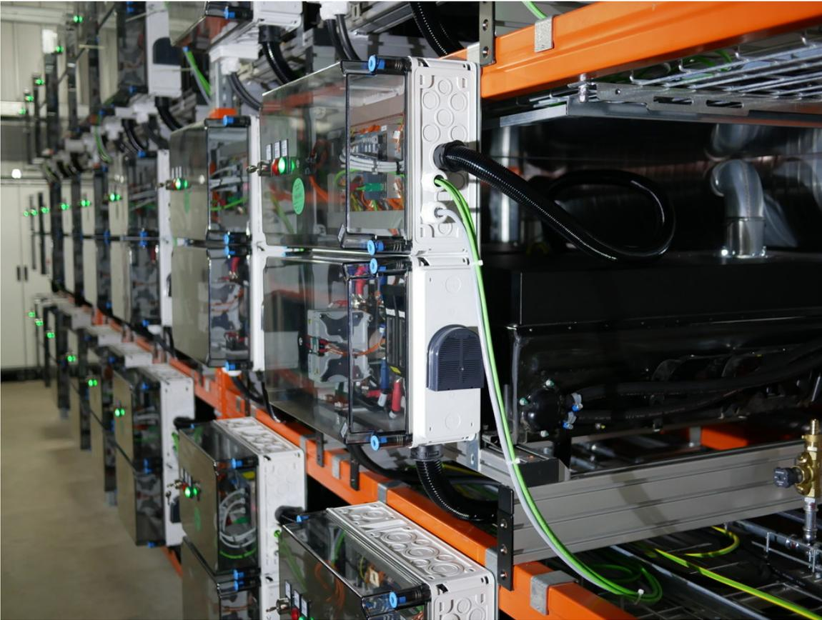
2nd-Use-Batteriespeicher mit 13 MWh aus 1000 gebrauchten Smart-Electric-Drive-Batterien.
