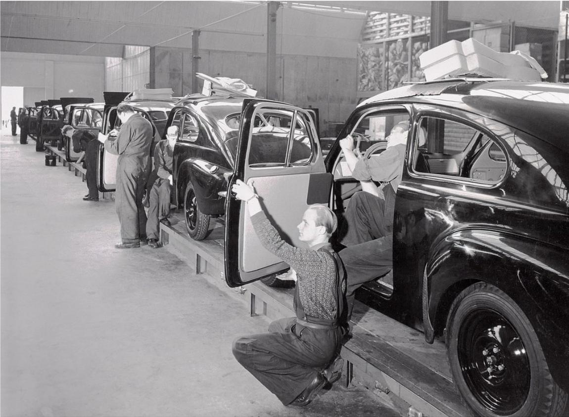
Produktion des PV 444 im Volvo-Werk Lundby (1948).
