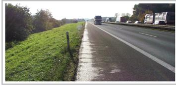
Optimaler Schadstoffrückhalt durch breitflächige Entwässerung über Bankett und Böschung an einer Autobahn.
