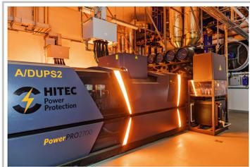
Das Datenzentrum am Skoda-Stammsitz hat eine dynamische Sicherungsenergiequelle, die auf kinetischer Basis arbeitet.
