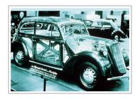
Mit einem "gläsernen" Modell zeigte Opel auf der Berliner Automobilausstellung 1935 das Konstruktionsprinzip der selbsttragenden Ganzstahlkarosserie des Olympia.
