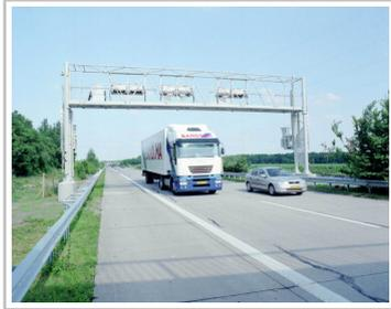
Kontrollbrücke zur Überwachung der Lkw-Maut.
