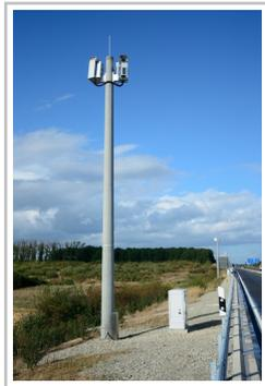
Testfeld Niedersachsen: Über 71 Masten sowie Messstationen sammeln die Verkehrsforscher des DLR an der A 39 Daten in Echtzeit.
